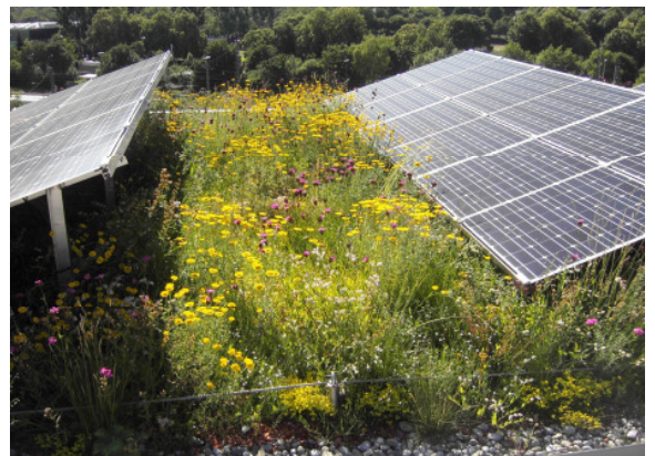
Dachflächen Regierungspräsidium Stuttgart
